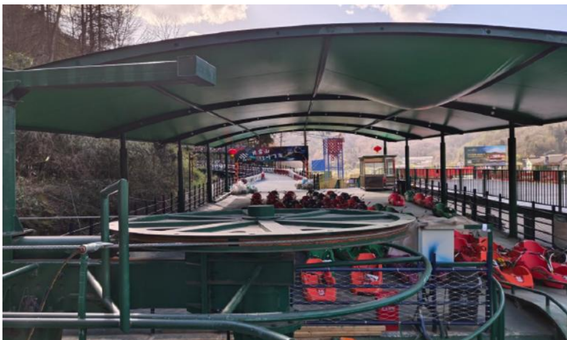
图4 下站平台建设现状图
