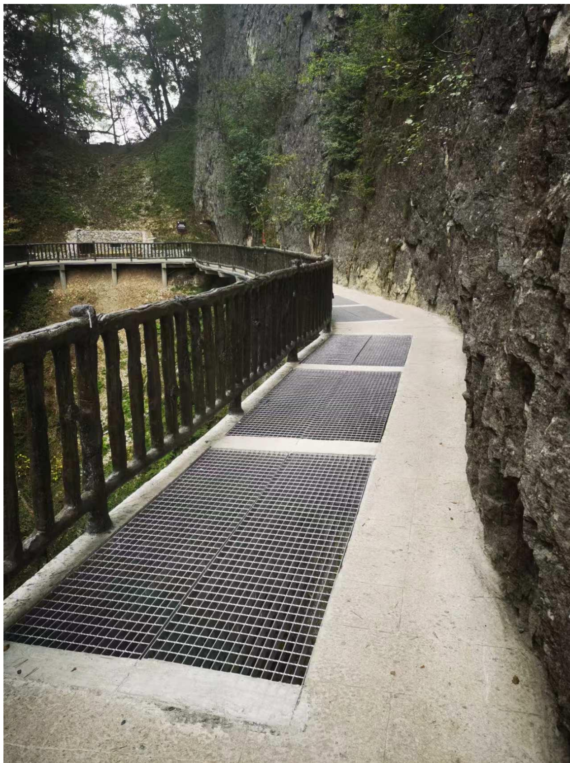
图10 燕子岭栈道建设现状（2）
