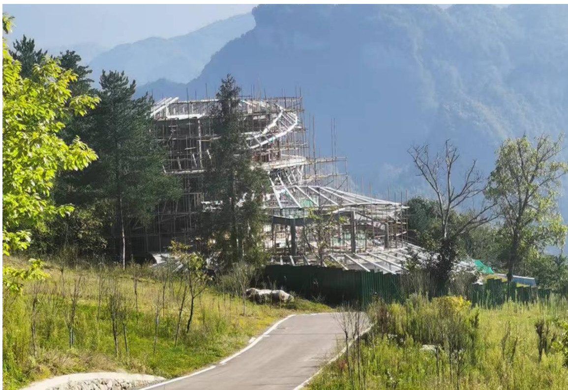
图6 普陀村民综合服务中心建设现状
