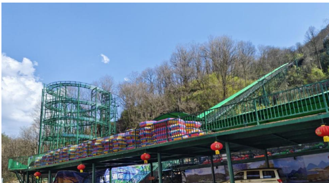
图2 下站平台建设现状图
