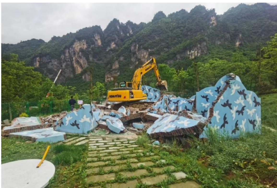
图7 桃源村项目拆除过程影像
